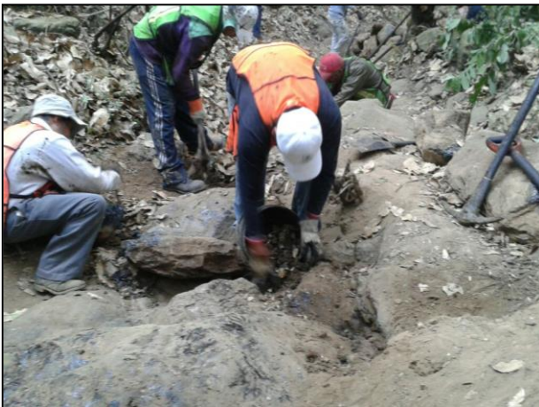
9.- Con apoyo de recurso humano se extrajo el material afectado a una profundidad superficial y fue depositado en tinas para su posterior acarreo a las celdas temporales de transferencia.
