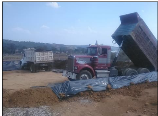
12.- Acarreo y depósito de material edáfico afectado a celda provisional.
