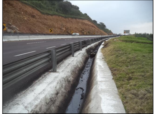
2.- Canaleta de concreto por la cual se desplazó el hidrocarburo hacia el suelo natural de la zona.
