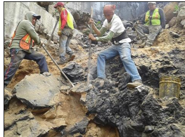
10.- Extracción de material edáfico afectado en zonas con difícil acceso a maquinaria pesada.
