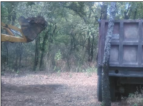
11.- Deposito de material edáfico afectado a camión de traslado.
