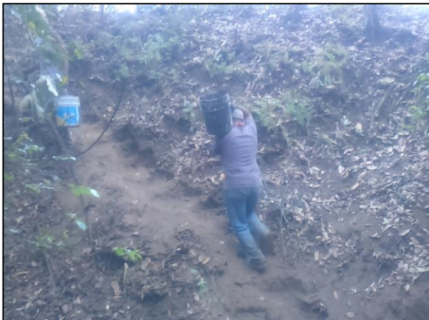
5.- Acondicionamiento de la zona de acceso a las zonas afectadas, construcción de peldaños (escaleras).
