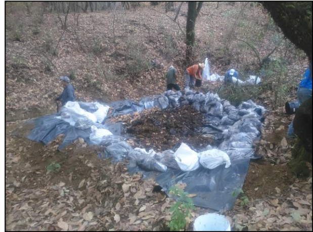
8.- Se construyen diversas celdas temporales de transferencia, donde se depositó el material edáfico afectado extraído.
