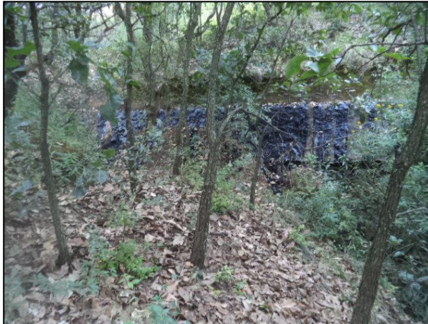
3.- Puente de piedra en la Zona B y por donde el Combustóleo continuó su recorrido total.
