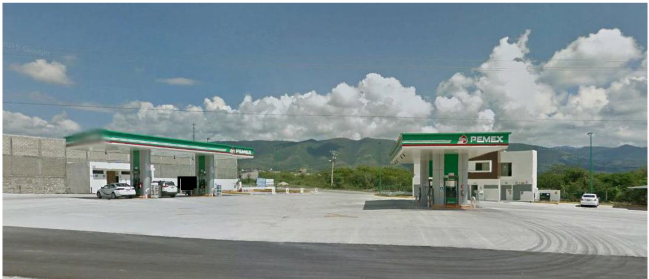
FIGURA 4.- Estado Actual de Estación de Servicio
