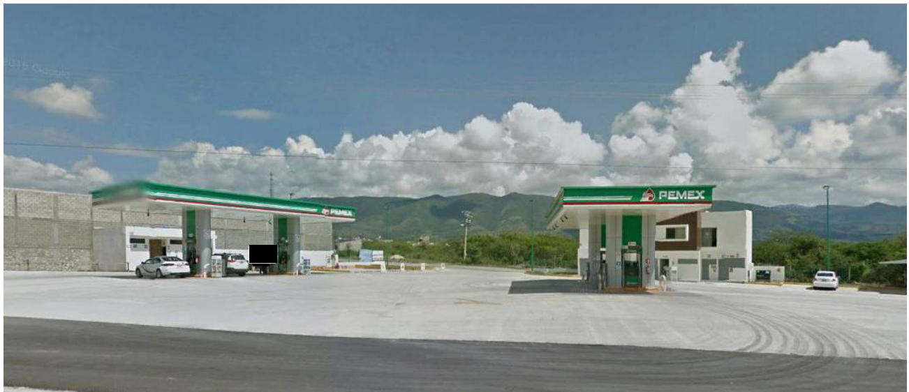
FIGURA 8.- Paisaje actual de la estación de servicio.
