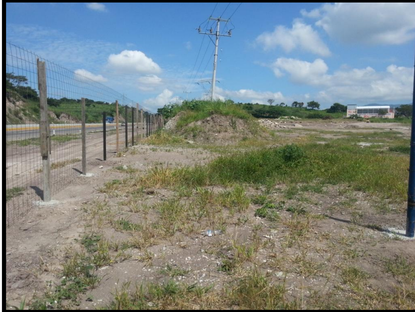
FIGURA 6. Tipo de suelo en el área donde se construyó la estación de servicio
