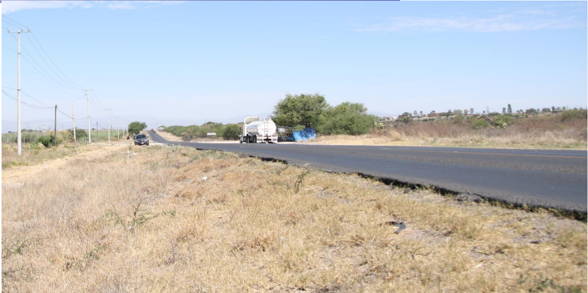
Fig. II.10 Carretera Estatal 411 Fuente: BICE 2015.
