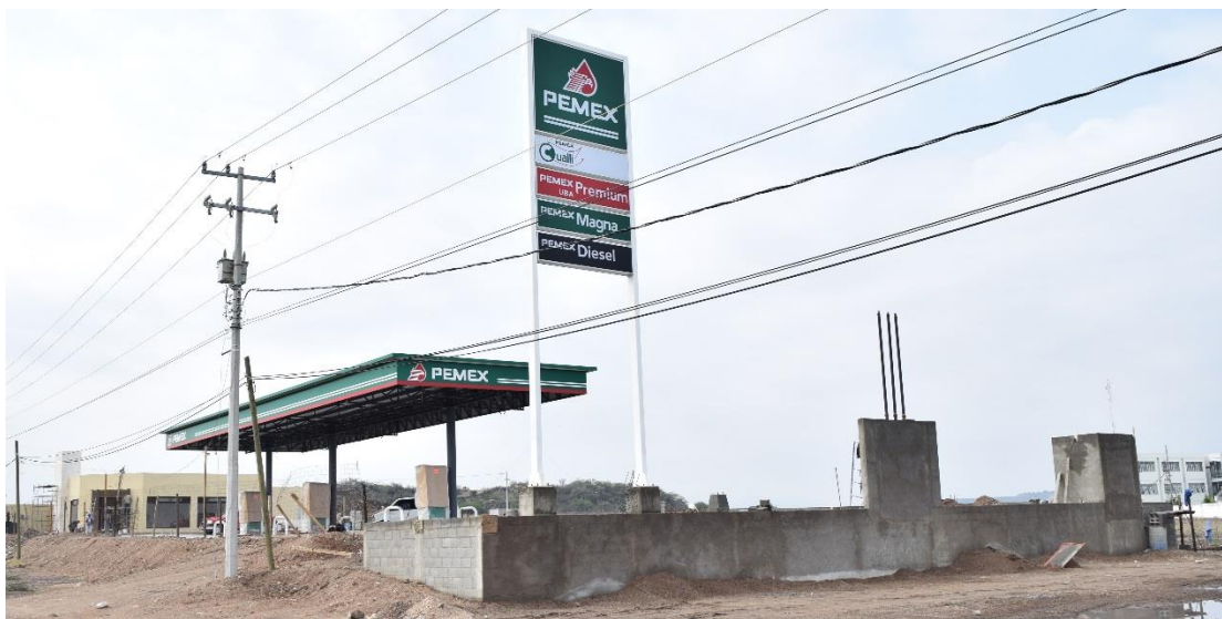
Fig. II.7 Vista actual del predio. Fuente: BICE 2016.
