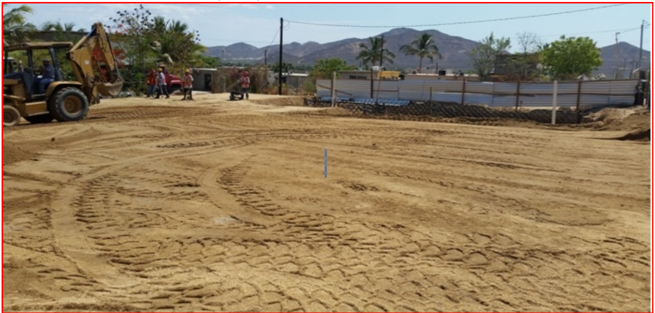
Imagen del predio al inicio de la construcción.
