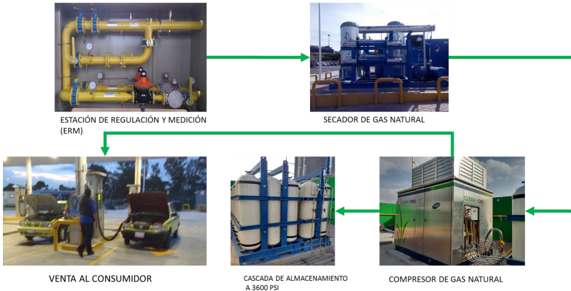
Figura II.8 Proceso del gas natural en la EDS
