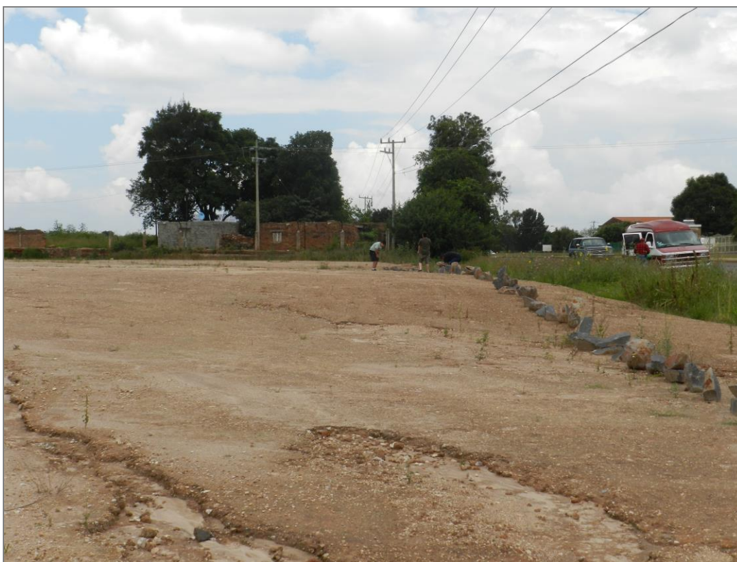
Fotografía 12. Imagen tomada del interior del predio hacia el Norte, obsérvese que la pendiente tiene orientación al Sur.
