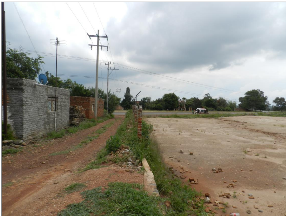
Fotografía 5. Esta toma se observa con orientación Oeste a Este en la delimitación de la propiedad, esta barda será derribada para la estación de servicio gasolinera.
