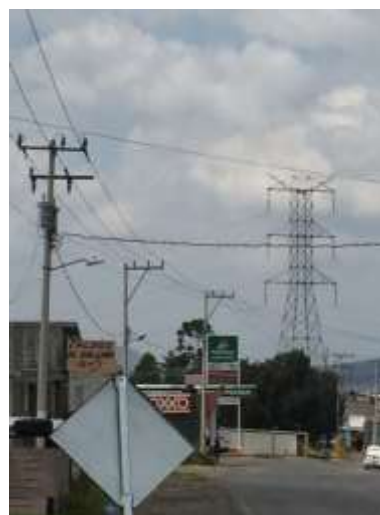
Colindancia Oeste. Carretera Tepeapulco Apan, tienda de conveniencia OXXO y Estación de Servicio PEMEX (a 500 m aproximadamente); línea de fluido eléctrico y media y alta tensión
