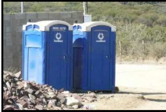
Ilustración 2. Ejemplo de Establecimiento de Sanitarios Portátiles en las Etapas de Construcción
