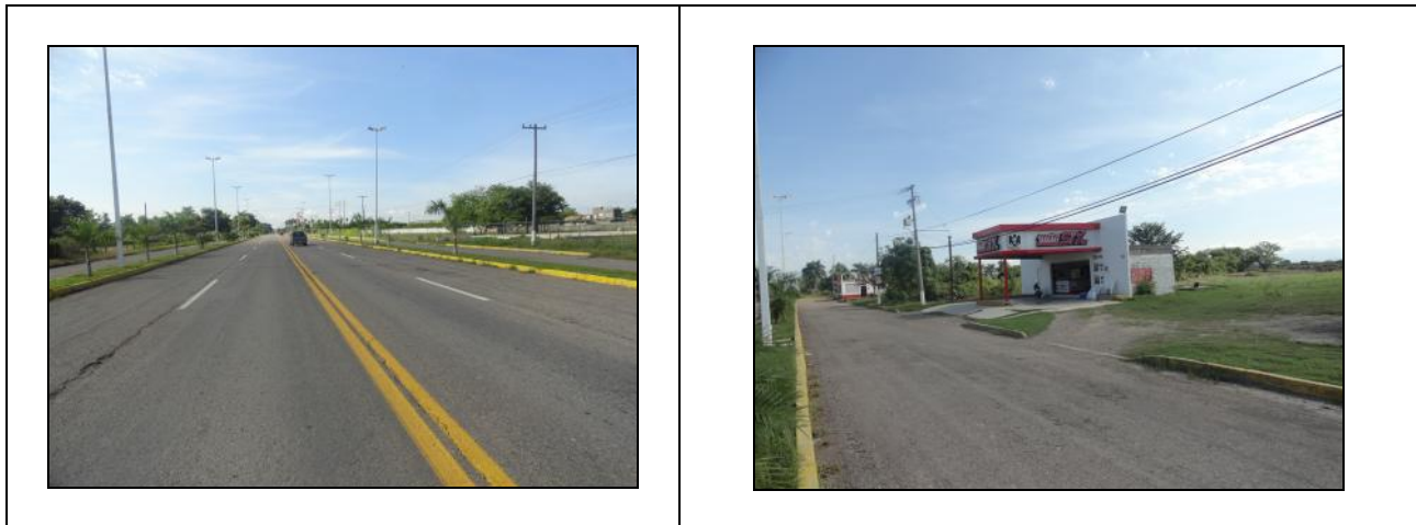
Fotos 1-2 Se observan las condiciones en que se encuentra la carretera que conduce hasta el sitio del proyecto.
