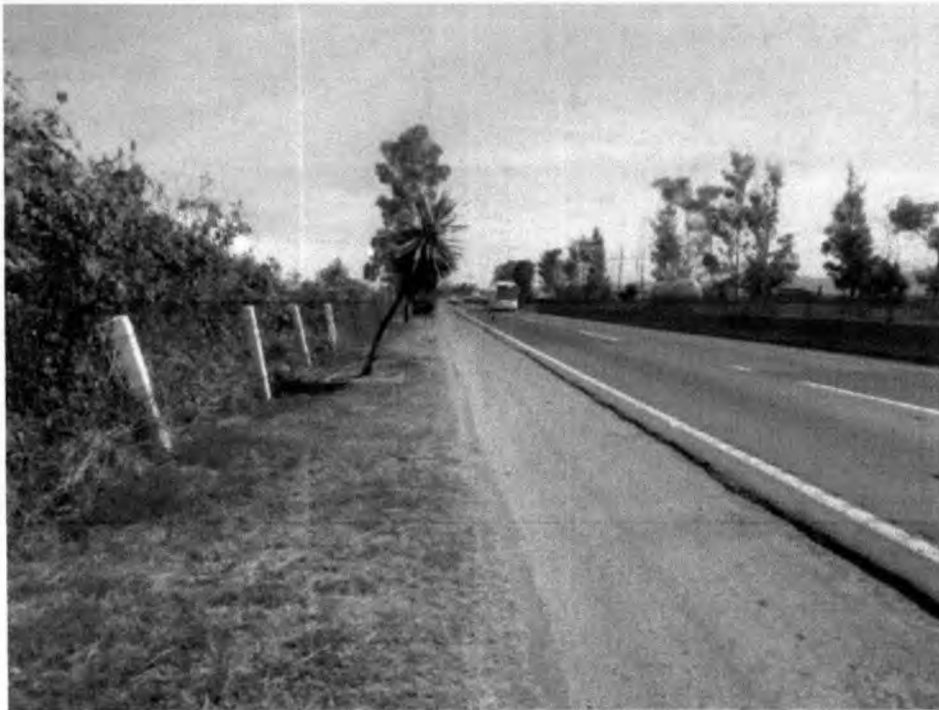
Fotografía 6. Vía de acceso
