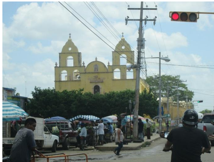
Fotografía 6 Urbanización de la zona del proyecto.
