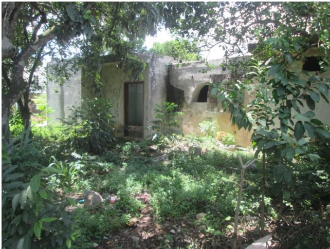
Fotografía 7 Condiciones actuales del área del proyecto.
