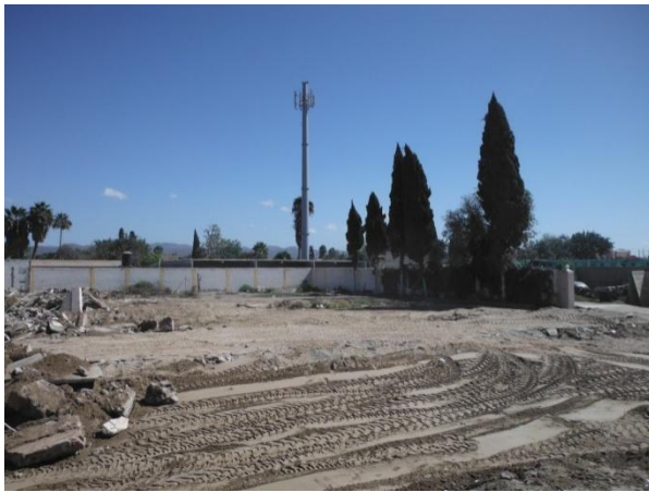
Foto 5.- Predio y al fondo Colindante al este .
