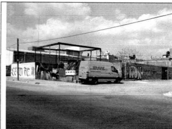
Foto 5. Cuadrante II – Vista de sur-poniente a nor-oriente (Zona de servicios)
