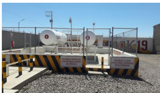
Suministro de gas Lp al tanque de la estación de carburación
