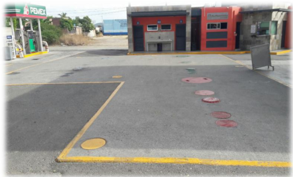
Área de tanques.
