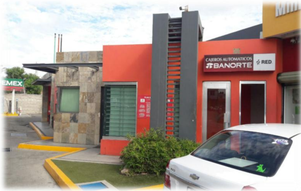
Cajero automático que forma parte del edificio de oficinas.
