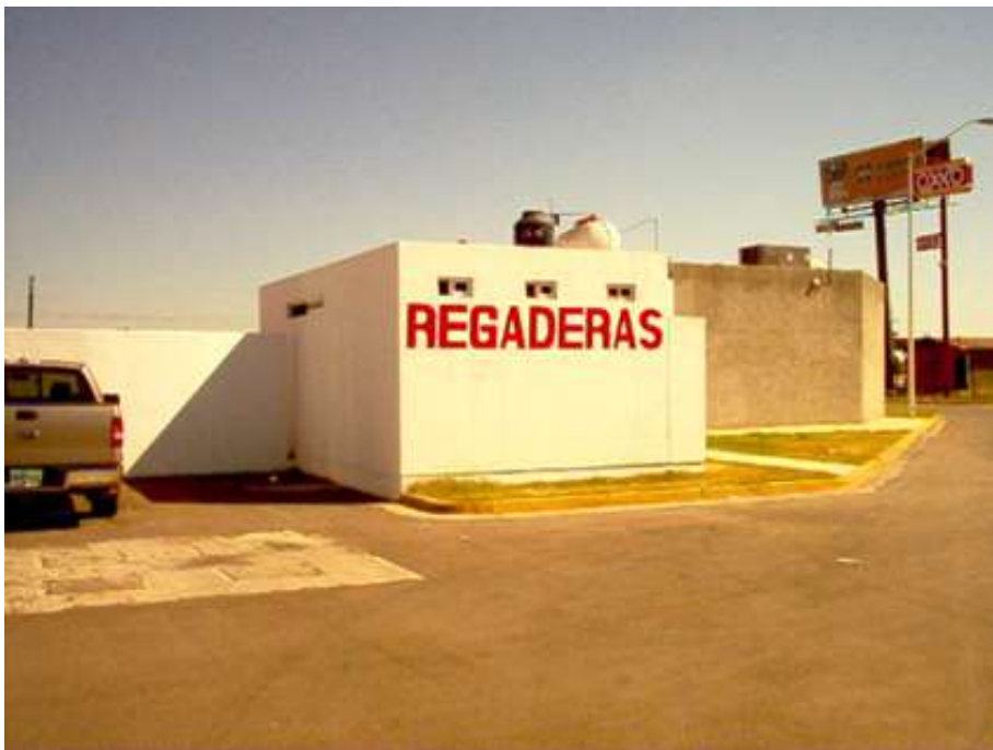
Módulo de baños y regaderas.
