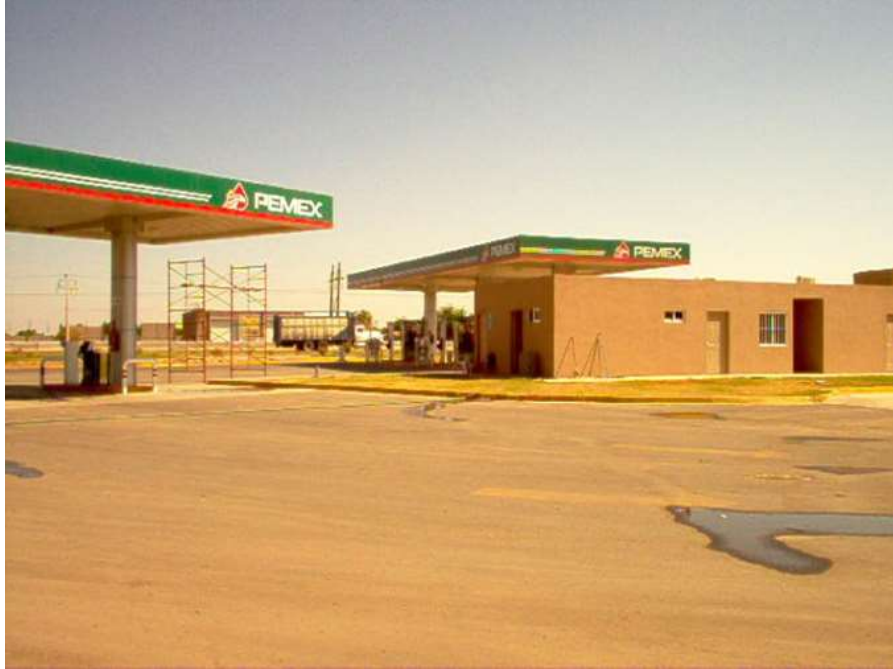
Parte trasera de la estación, se observa edificio de oficina y módulos de despacho
