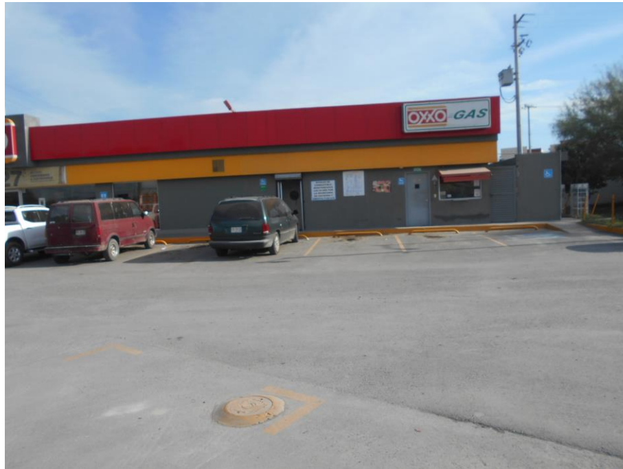
Figura 3. Tienda de conveniencia asociada a la estación de servicio.
