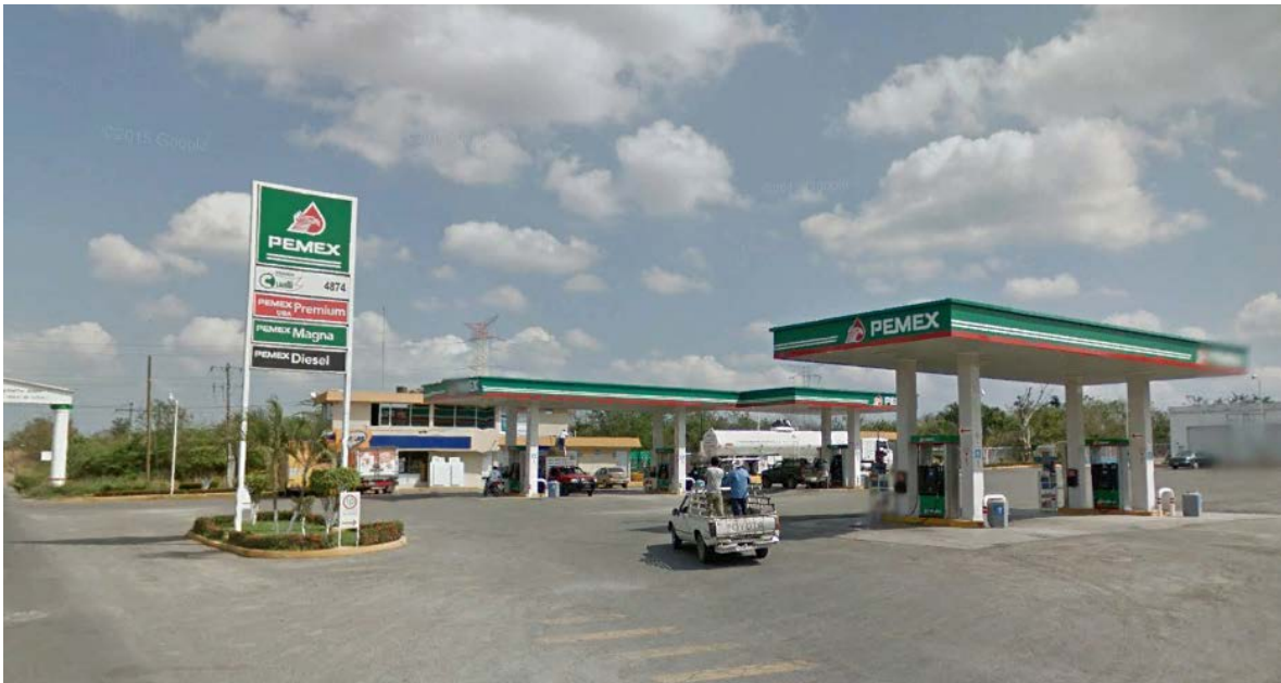
Vista de la Estación de Servicio
