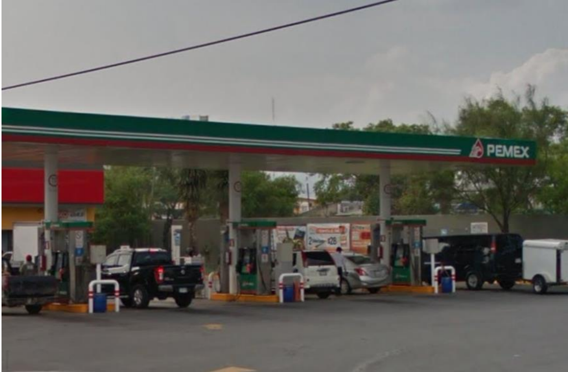
Figura 1. Vista frontal de la estación de servicio.
