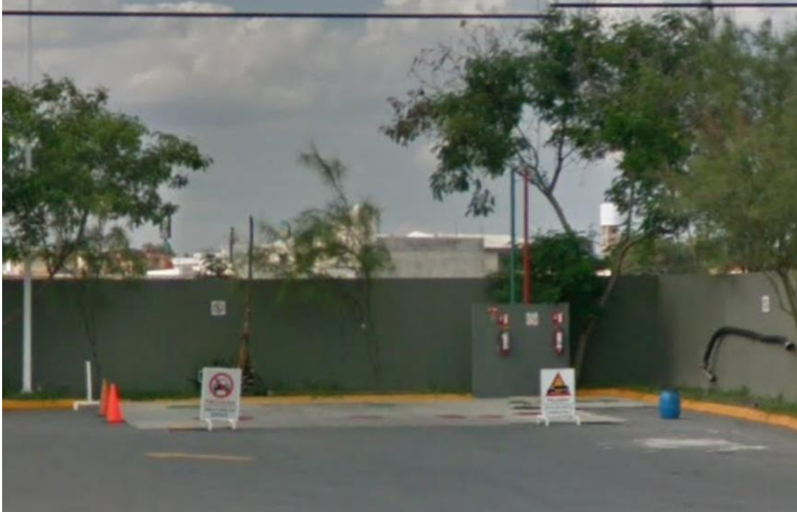
Figura 3. Área de tanques de almacenamiento de la estación de servicio.
