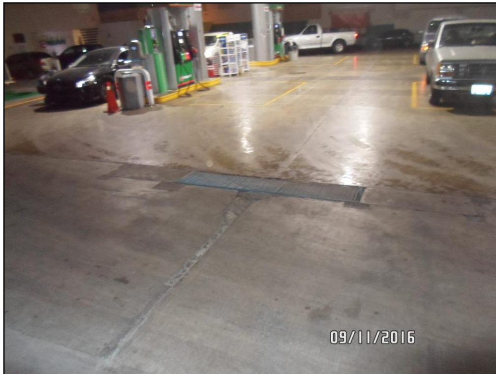
Imagen 3. Rejillas para las trampas de aceites.
