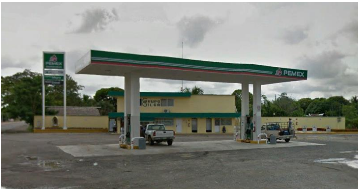
Fotografía 1. Vista general de la Estación de Servicio
