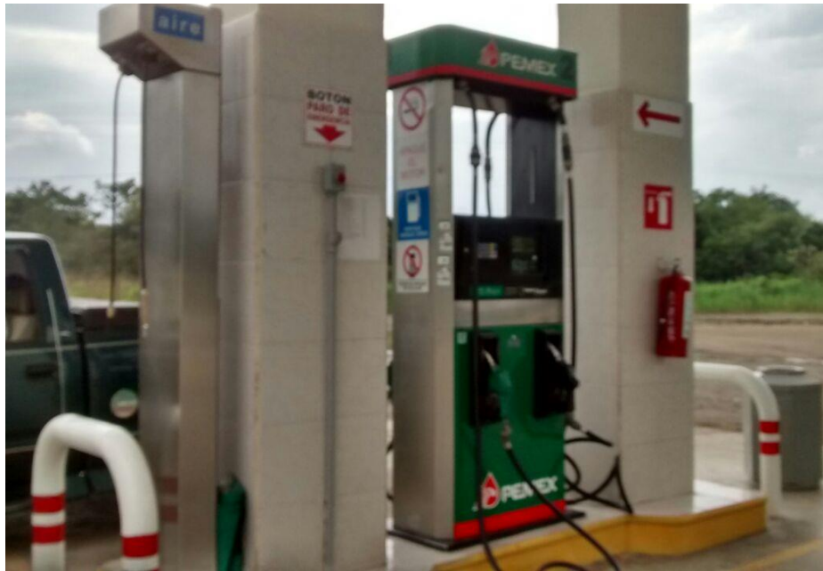
Fotografía 4. Vista general de dispensario.
