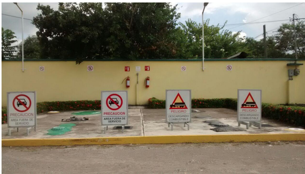
Fotografía 5. Zona de tanques.
