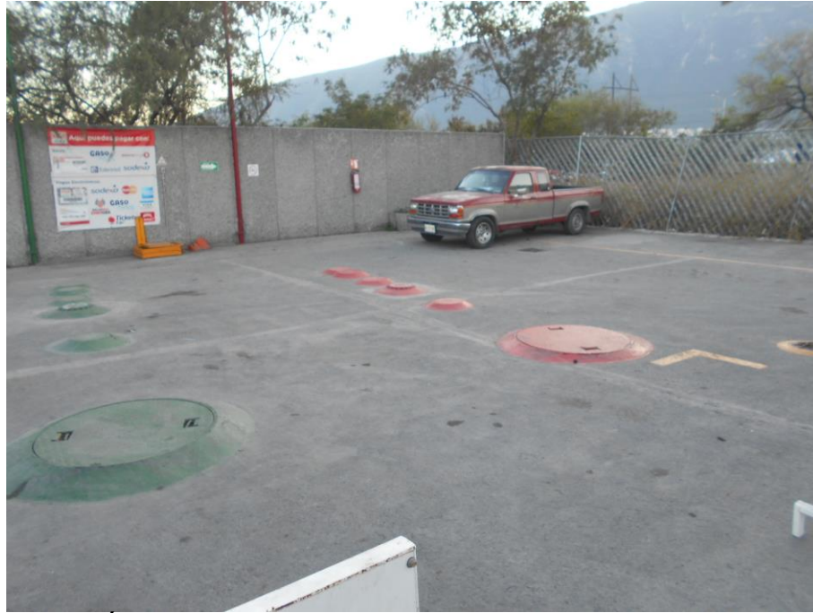
Figura 5. Área de tanques de almacenamiento de la estación de servicio.
