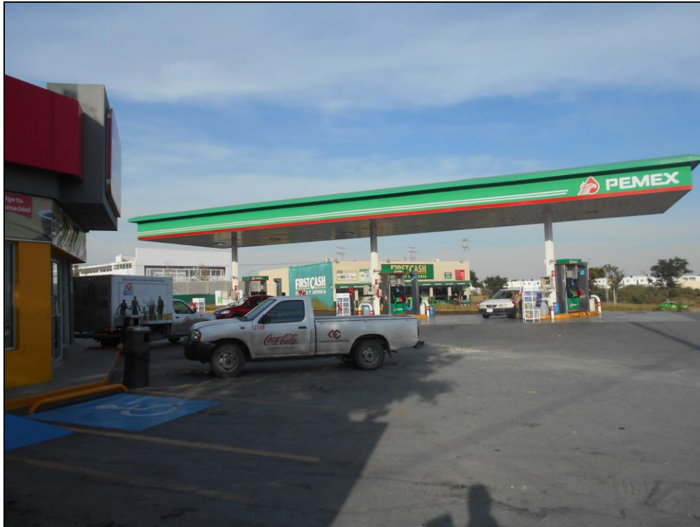
Figura 1. Vista general de la estación de servicio.
