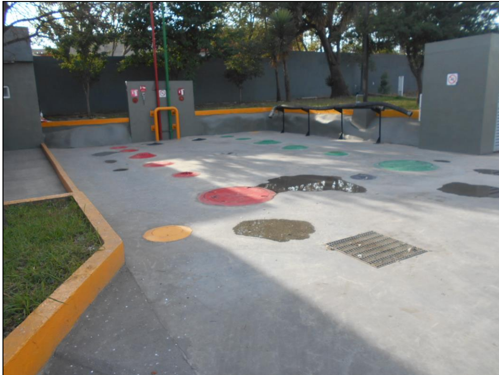
Figura 3. Área de tanques de almacenamiento.
