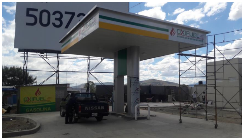
Imagen 1. Infraestructura para venta de Etanol en construcción.
