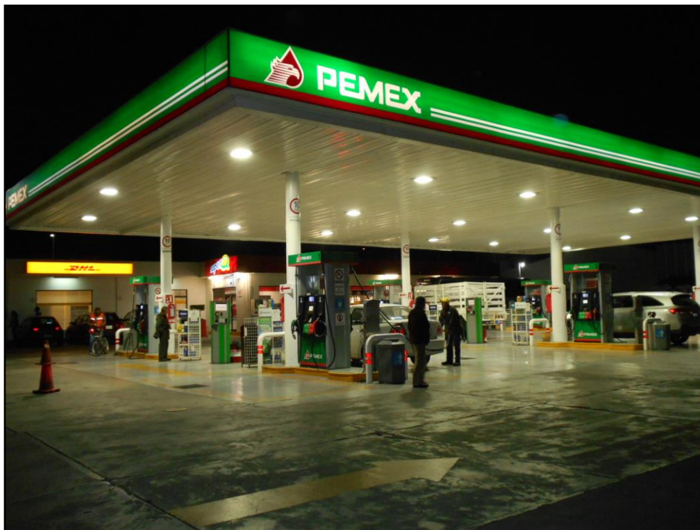
Imagen 1. Vista de la estación de servicio.
