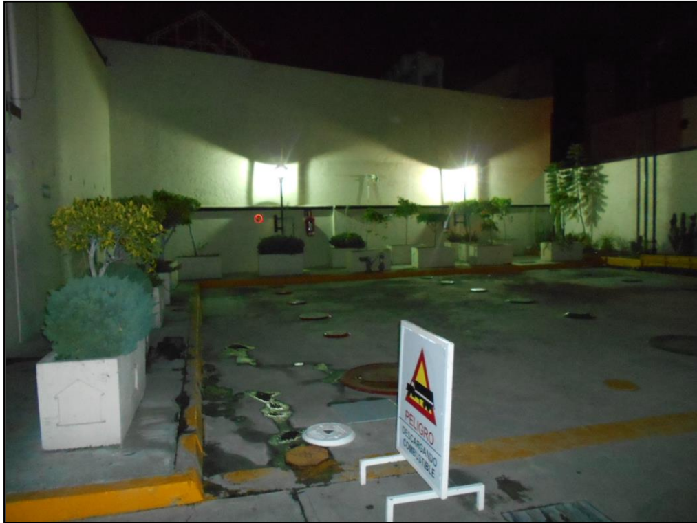
Imagen 3. Área de recarga de tanques.
