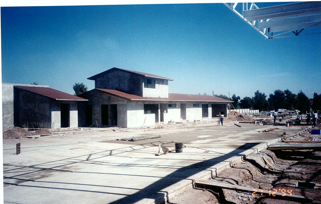
Imágenes 5 y 6: Etapa de obra previo al inicio de operaciones el 10 de enero de 1995´ Oficinas Generales e Islas de despacho de gasolina. fuente: Distribuidora Del Sur de Salamanca S.A. de C.V.
