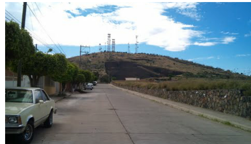
.-Calle Soto Inés, Torres microondas Fuente: Google Earth 2015
