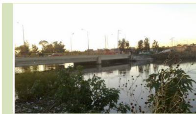
-Zona Río Lerma Fuente: Fotografía tomada en sitio.
