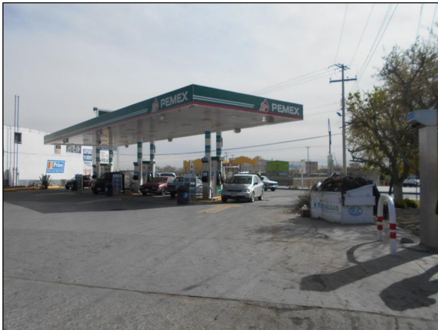
Imagen 2. Área de despacho en estación de servicio (Actualmente inactiva).
