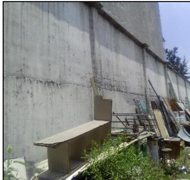
El predio actualmente cuenta con una barda de colindancia construida a base de concreto armado como se observa en las imágenes, este muro tiene una altura de 5.50 m; y el acero de refuerzo es de barras de 1/2" en ambos sentido con una separación de 20 cm.
