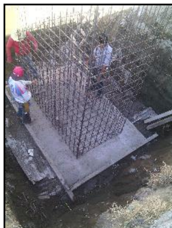
Figura 9. Armado de la trampa de grasas
