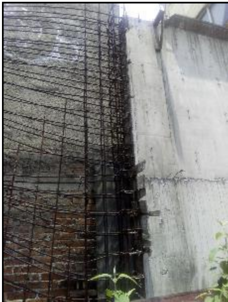
El predio actualmente cuenta con una barda de colindancia construida a base de concreto armado como se observa en las imágenes, este muro tiene una altura de 5.50 m; y el acero de refuerzo es de barras de 1/2" en ambos sentido con una separación de 20 cm.
