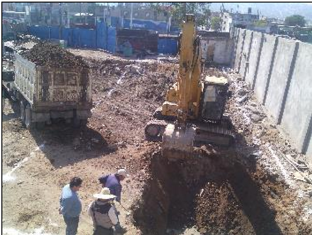
Figura 4. Ejemplo de la excavación
