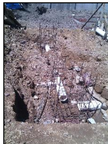
Figura 9. Armado de la trampa de grasas
