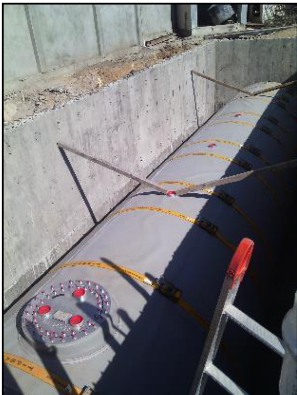
Figura 6. Detalle de anclaje
