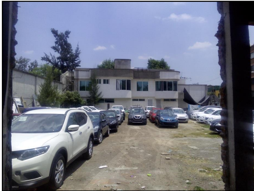
Vista de la construcción que servirá como edificio de servicios y oficinas, imagen capturada desde el interior de la construcción que sirve de bodega.
