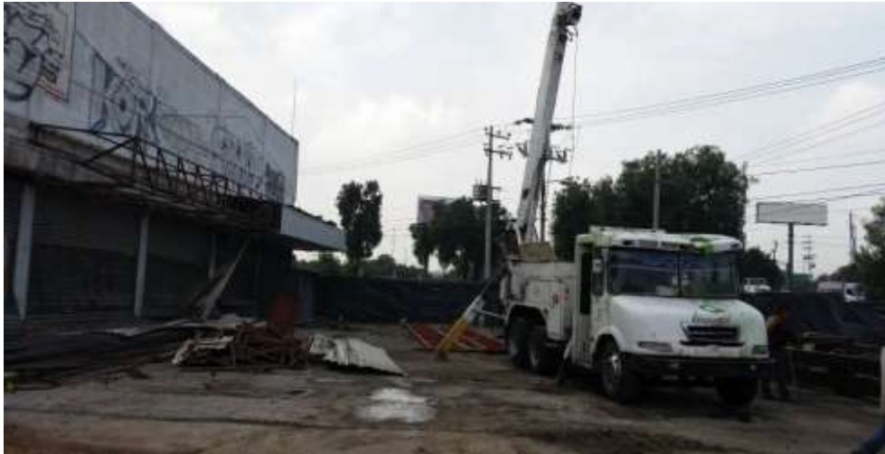
Figura 27. Barda perimetral de 2.5m alrededor del predio.
