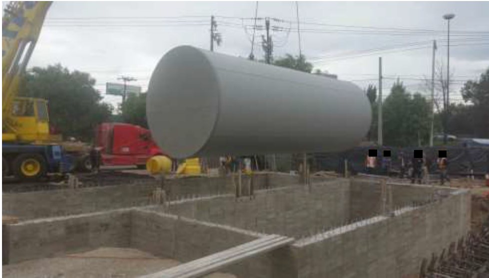
Figura 24. Tanque de almacenamiento de combustible.
