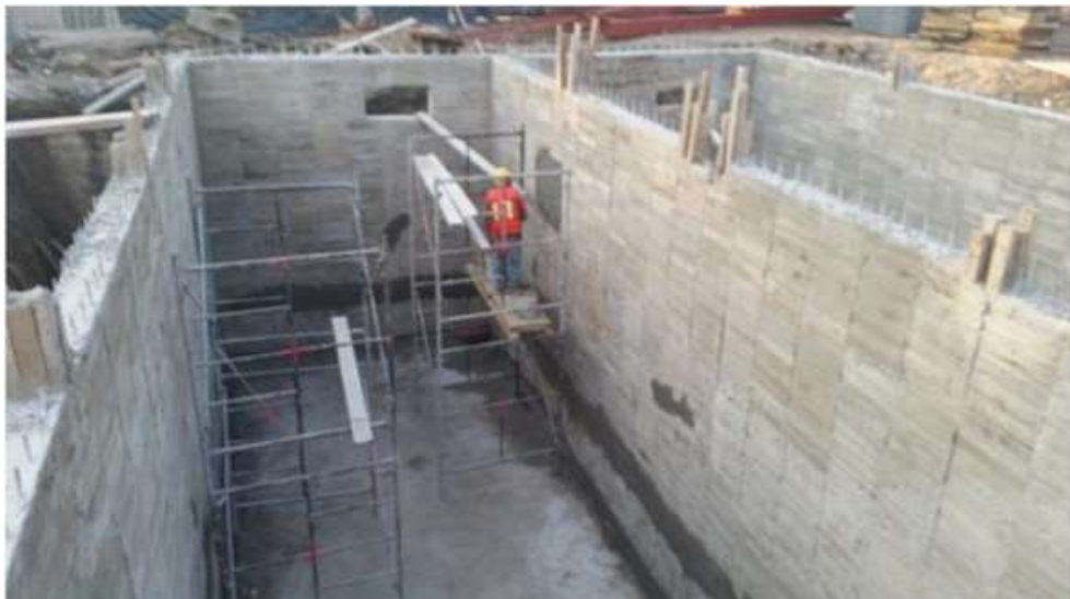
Figura 26. Otra vista de las fosas de concreto.
