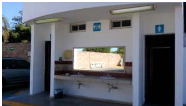
Figura 13. Evidencia fotográfica de área de sucios, área de sanitarios para empleados, y al público, señalamientos de área de precaución, Imagen frontal de acceso a Cuarto Eléctrico y Cuarto de Máquinas.
