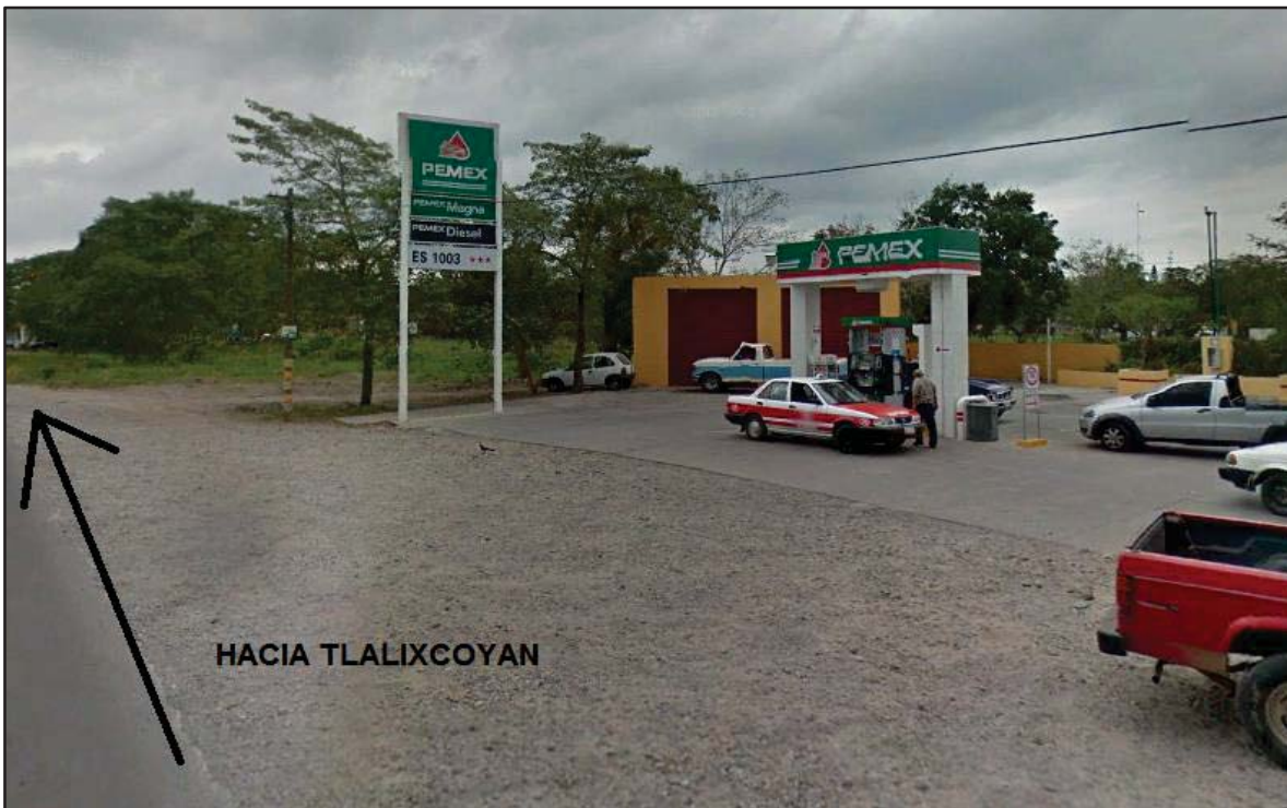
FIGURA 2. VISTA DE LA ISLA DE DESPACHO DE COMBUSTIBLES DE LA ESTACIÓN DE SERVICIO No. 1003
