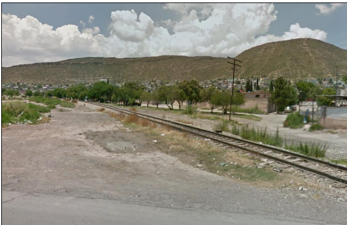
Figura 2. Vías ferroviarias colindantes al predio en evaluación.
