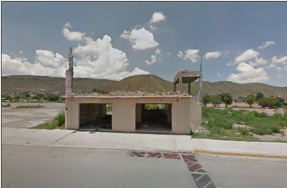
Figura 3. Construcciones abandonadas dentro del predio en evaluación.
