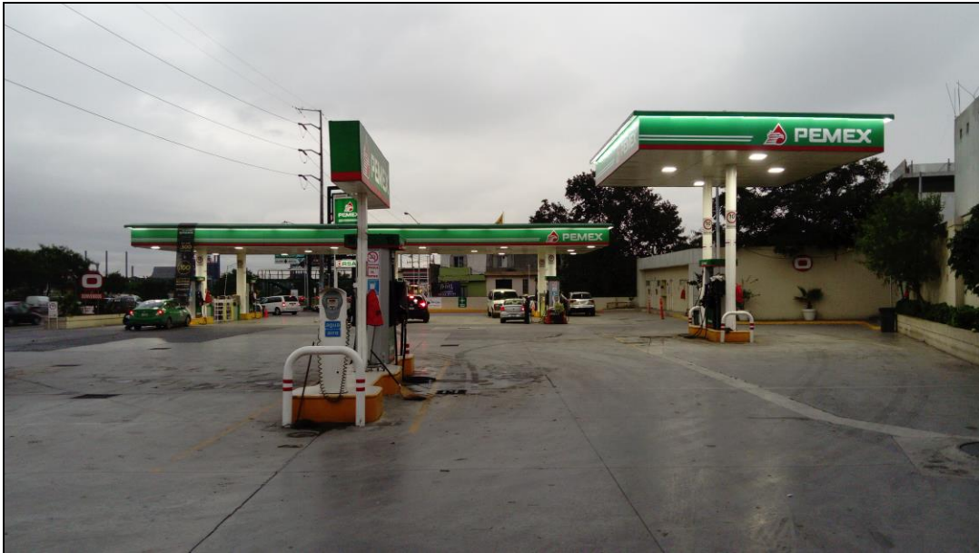
Figura 1. Vista lateral de las instalaciones de la estación de servicio.
