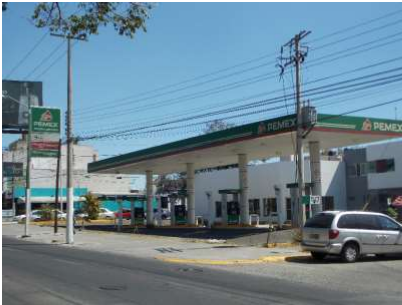
Figura 1. Estación de servicio “Superestación Patria Tepeyac S.A. de C.V.”. Fuente: SAP Servicios Ambientales Profesionales.
