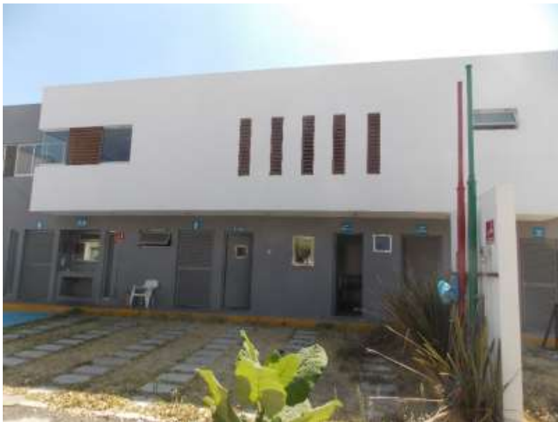
Figura 11. Oficinas en la construcción de la estación de servicio. Fuente: SAP Servicios Ambientales Profesionales
