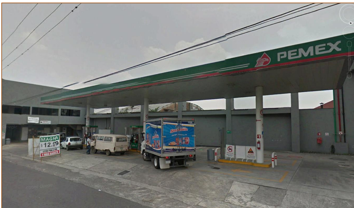
Imagen Lateral de la Estación de Servicio 10358 “COMBUSTIBLES REAL” con dirección al N al S Sobre Boulevard Córdoba- Peñuela
