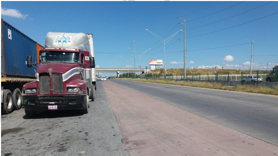
Vista de la Vía Rápida al Aeropuerto hacia al Aeropuerto y al fondo se observa el puente de la Carretera Huinalá-Pesquería
