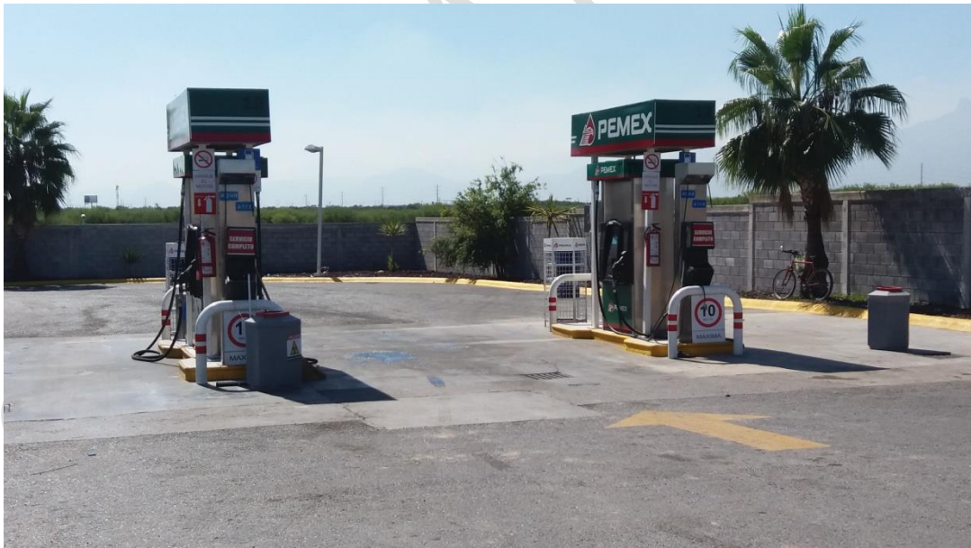
Vista de las estaciones de suministro de Diesel ubicado al fondo del predio (al Oeste)
