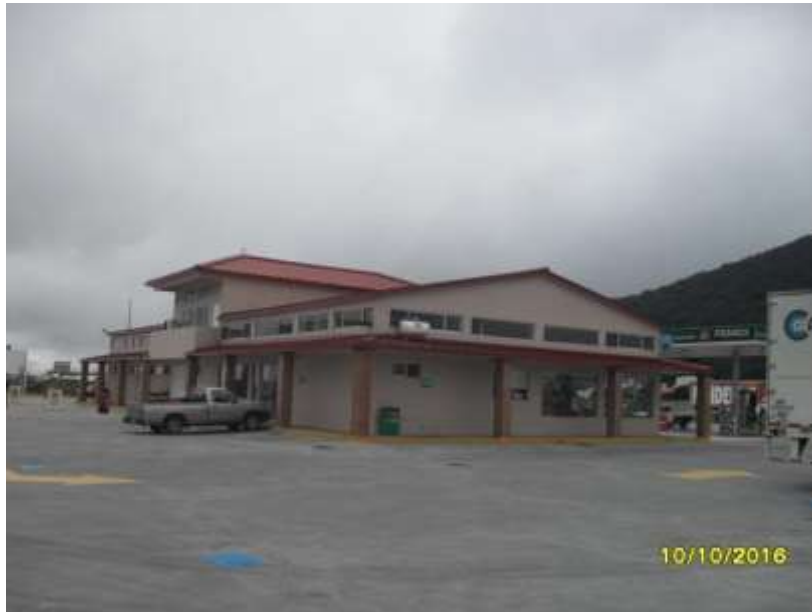
Fotografía 10.- Se observa edificio de la Estación de servicio.
