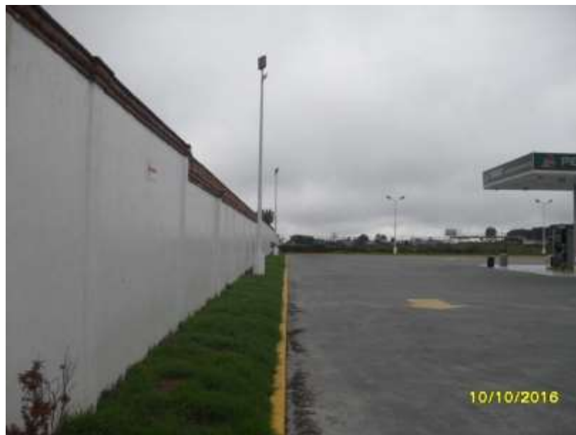
Fotografía 13.- Se observa área norte de la Estación con barda perimetral con área verde.
