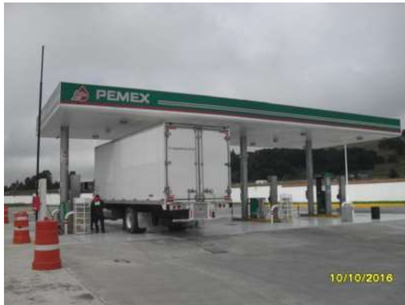
Fotografía 12.- Se observa área de dispensarios de diesel.
