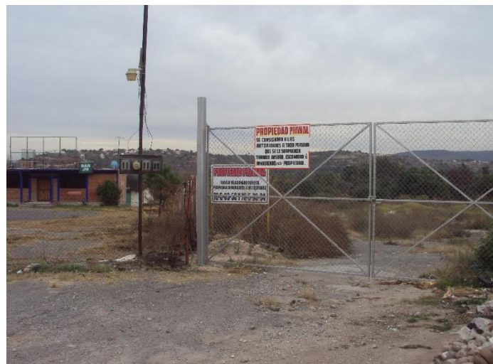
Figura 7. Vista en colindancia sur
