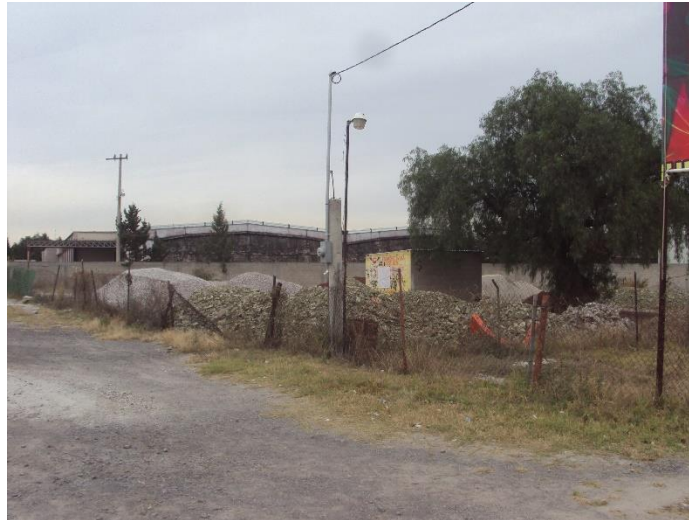
Figura 6. Vista en colindancia norte
