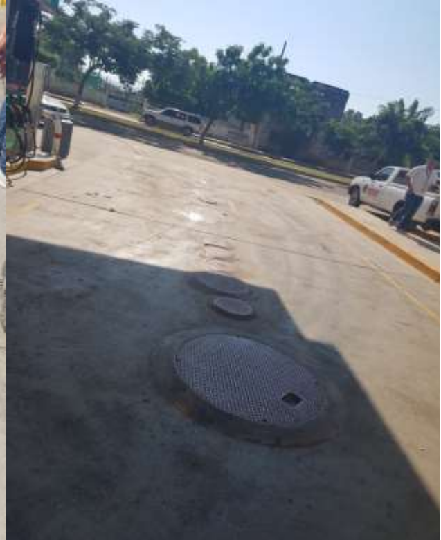
Fotografía 6.- Vista de la zona de tanques.
