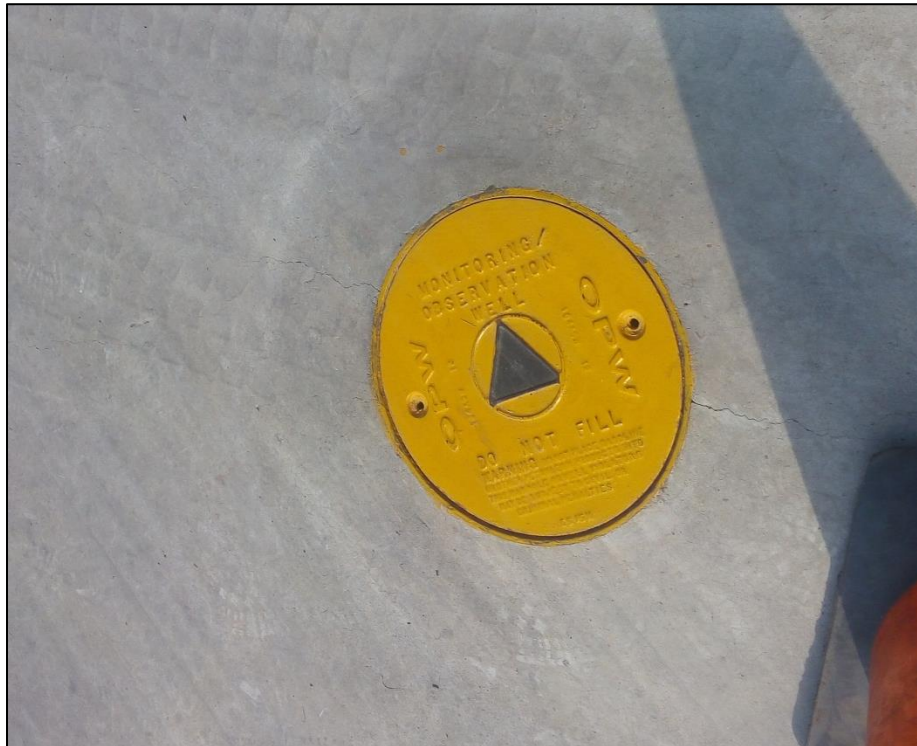
Fotografía 7. Vista superior del Pozo de Observación.
