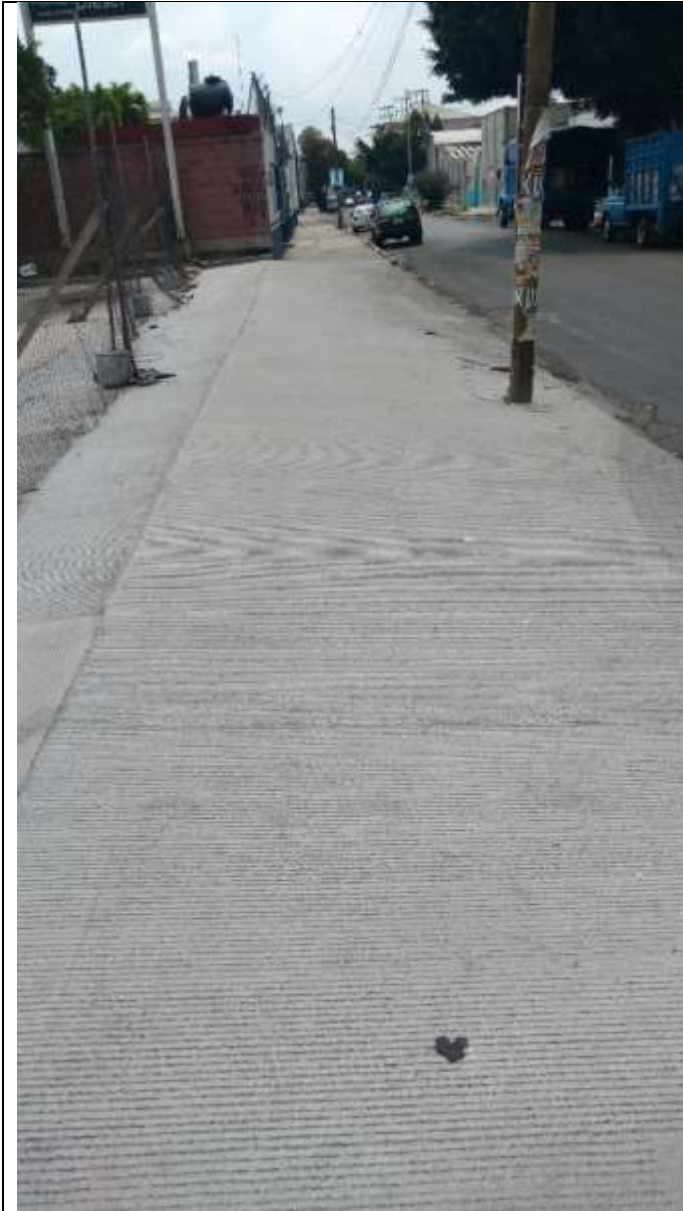
Figura 18. Vista exterior hacia la calle de Pino.
