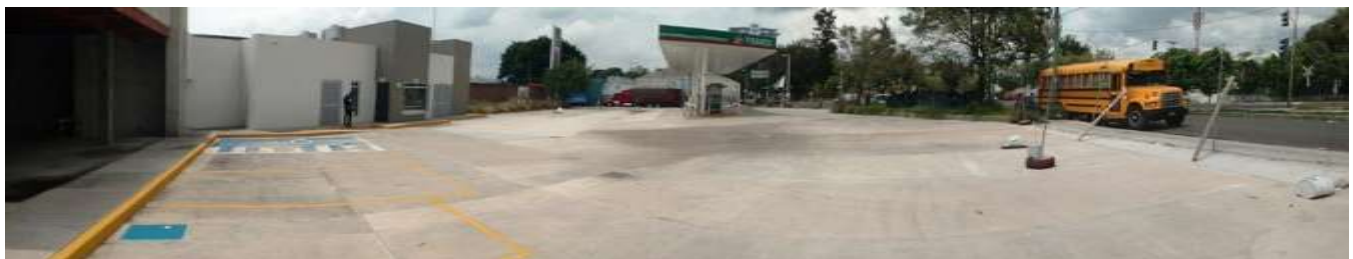
Figura 15. Vista panorámica de la estación.
