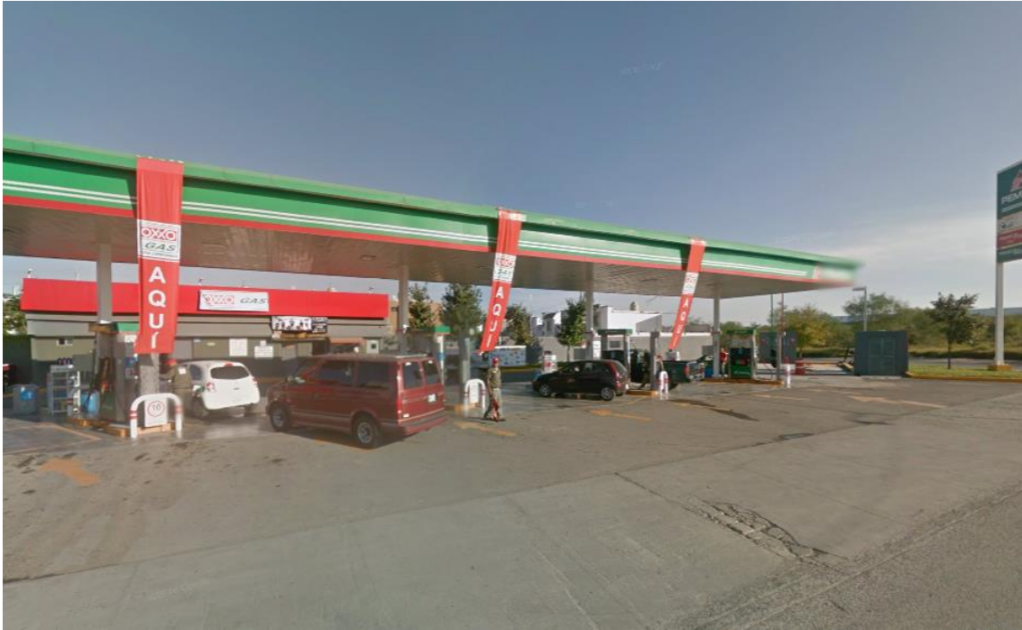
Figura 1. Vista frontal de la estación de servicio.
