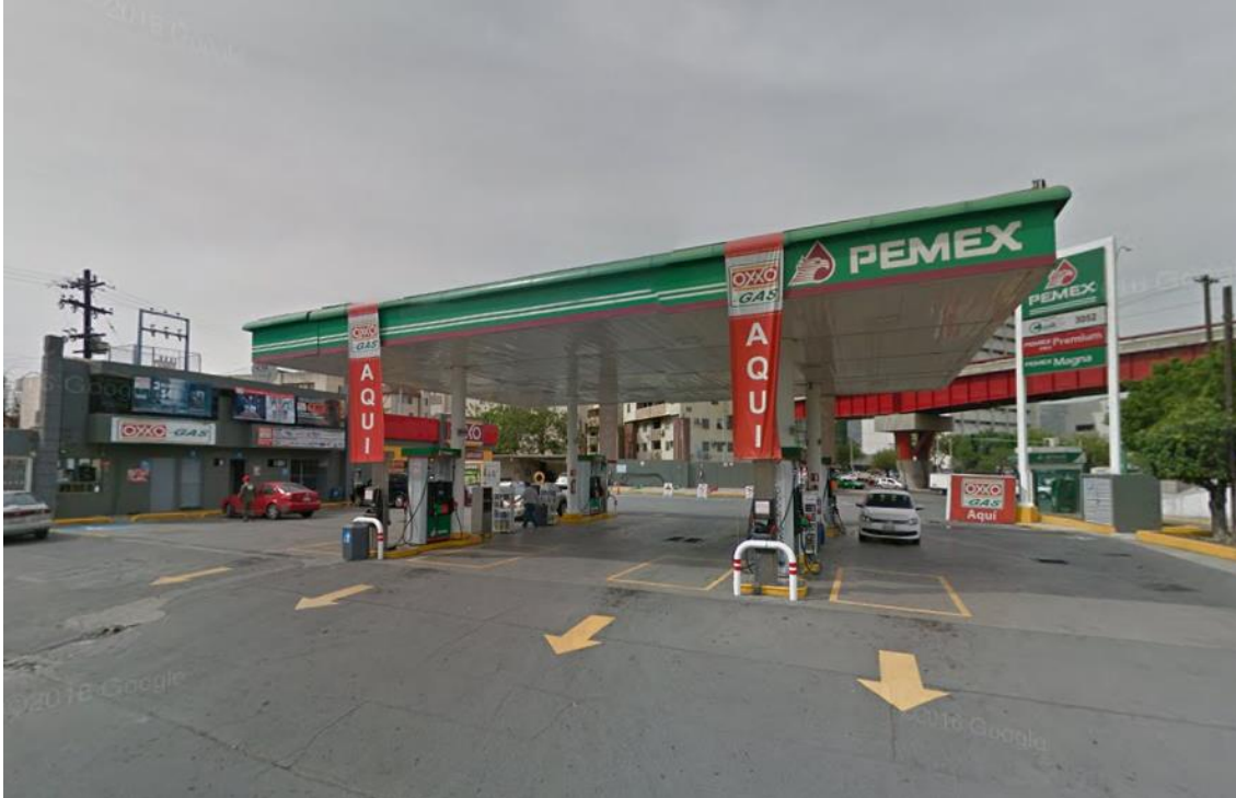
Figura 1. Vista frontal de la estación de servicio.
