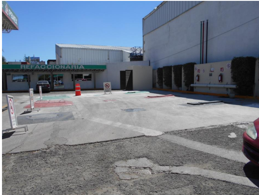
Imagen 3. Área de tanques de almacenamiento, a la derecha se aprecia el sistema de venteo normal y extintores.
