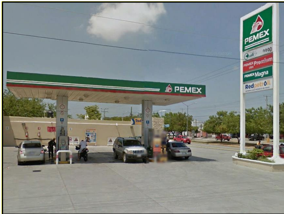
Fotografía 2. Vista lateral de la estación de servicio.
