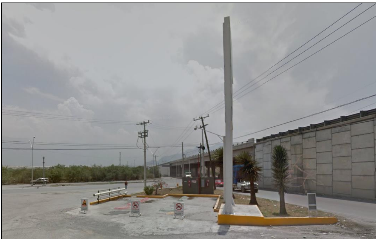
Figura 2. Área de tanques de gasolinas de la estación de servicio.
