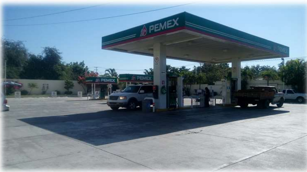
Estación de despacho de gasolina en funcionamiento.
