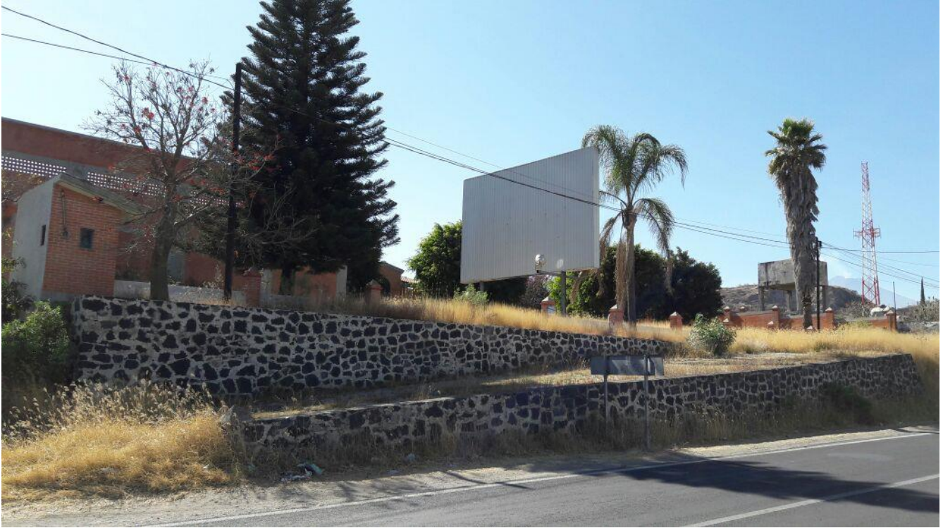
Figura 1 Vista al predio del proyecto desde el libramiento
