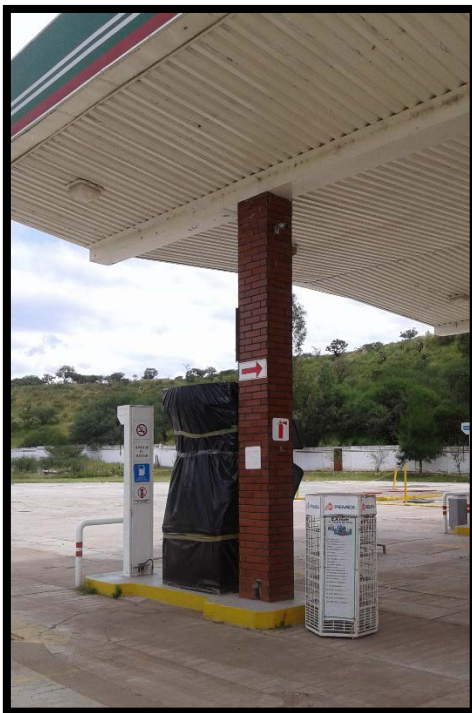
Dispensarios de Gasolina Magna y Premium. Cubiertos con naylon para evitar su deterioro.
