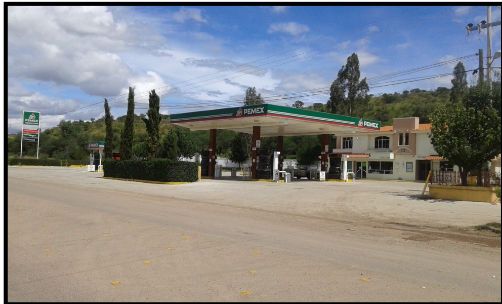
Estado actual de la Estación de Servicio. Vista desde la Avenida Nicolás Bravo saliendo del municipio en dirección a Fresnillo.
