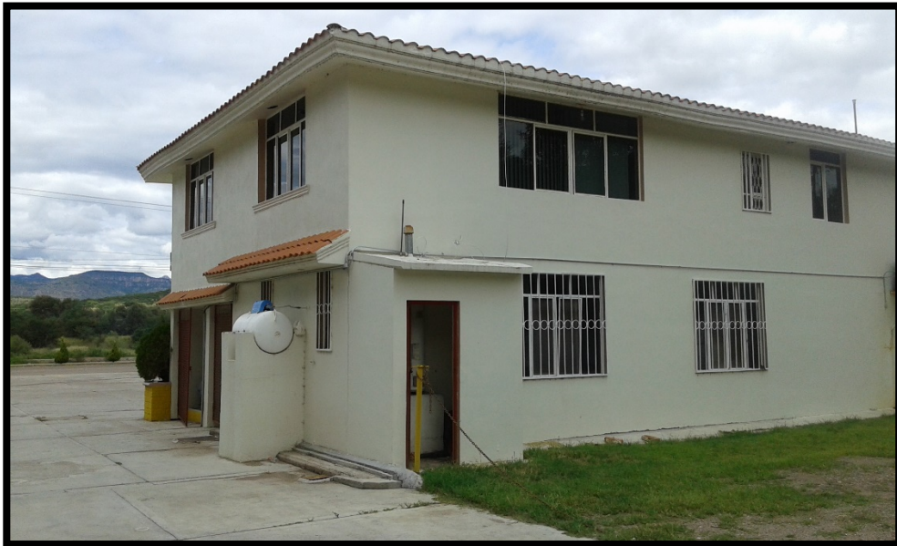
Edificio Comercial y de Servicios (Sur)
