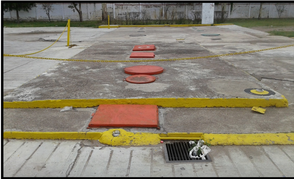
Área del Tanque de Gasolina Premium. Con una capacidad de 40 000 lts. Cubierta en la superficie con losa de 10 cm de ancho
