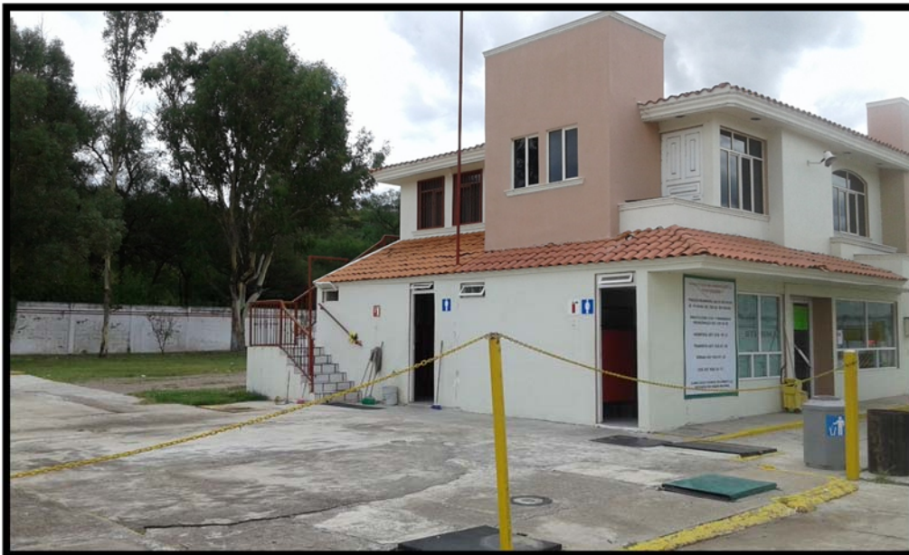
FIGURA 13 ÁREA DE SANITARIOS
