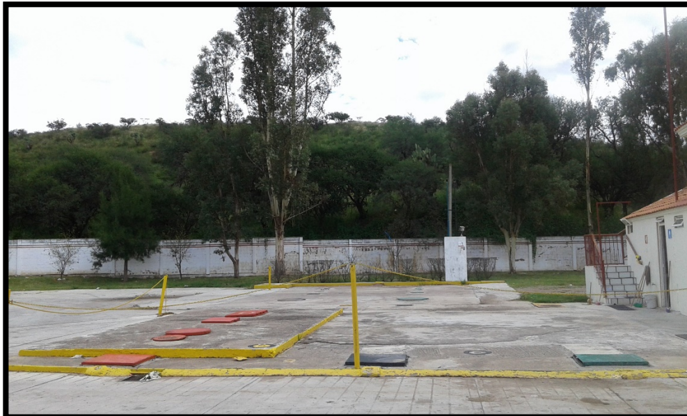
Área de Tanques
