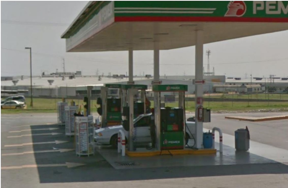
Figura 3. Dispensarios de la estación de servicio.
