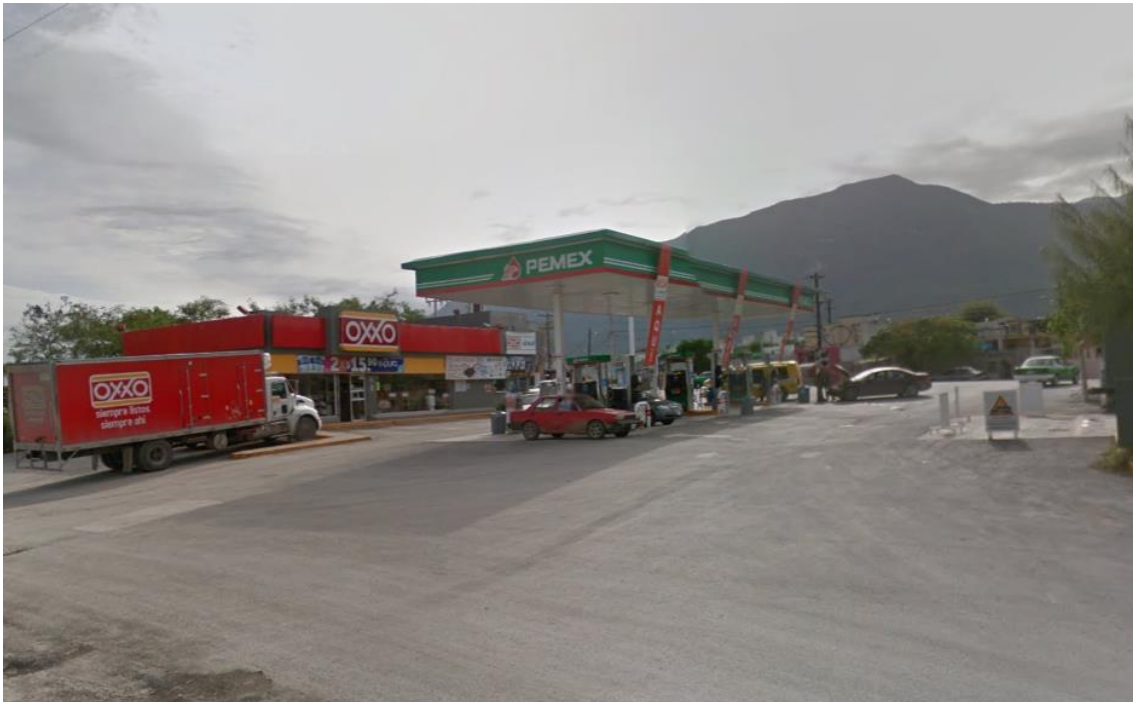
Figura 1. Vista frontal de la estación de servicio.
